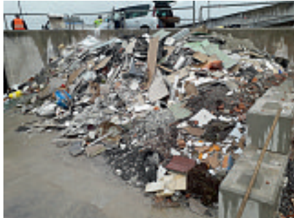
Die Fraktion Baumix, darunter fallen zB Gipsbeton, Holzfaserzement, Porzellan, Keramik und verunreinigter Bauschutt, kann nicht verwertet werden und wird deshalb auf einer Baurestmassendeponie abgelagert.
