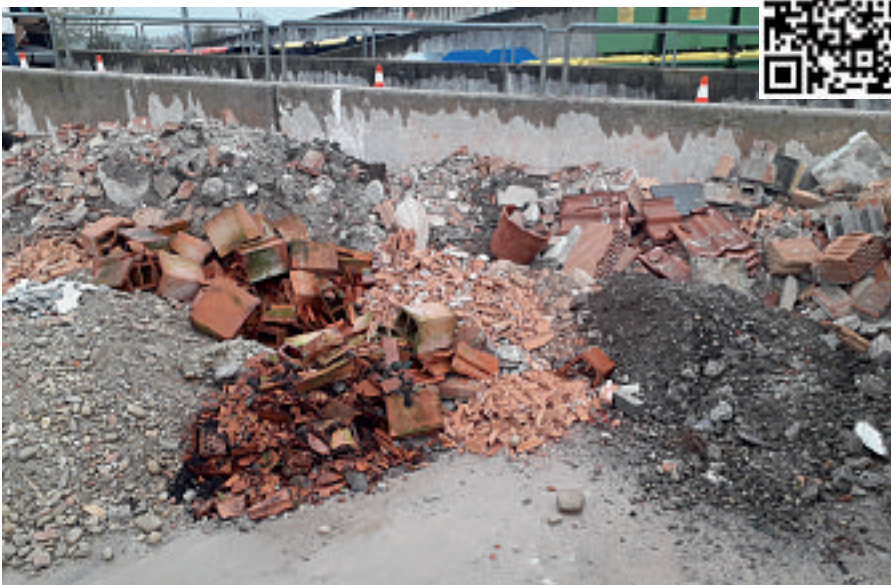
Recyclingfähiger Bauschutt wird zu recycelten mineralischen Hochbau-Restmassen weiterverarbeitet sowie für Künettenverfüllungen, Hinterfüllungen und Schüttungen verwendet.
